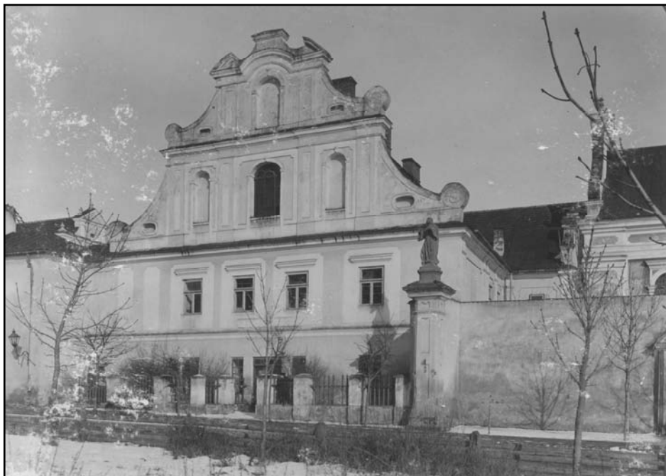
Budynek seminarium sandomierskiego (około 1906 r.)
