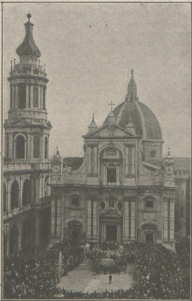
Facciata della Basilica
